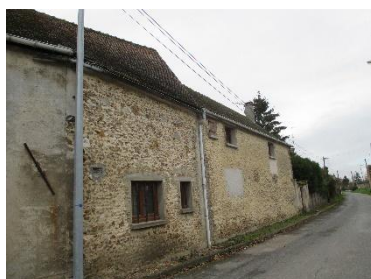
Construction en pierre
