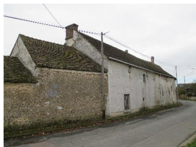
Construction en pierre
